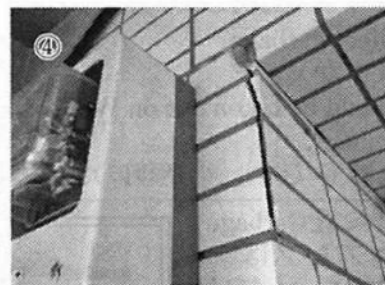
④ 建物の異常点検個所のポイント。大きく4つです。
